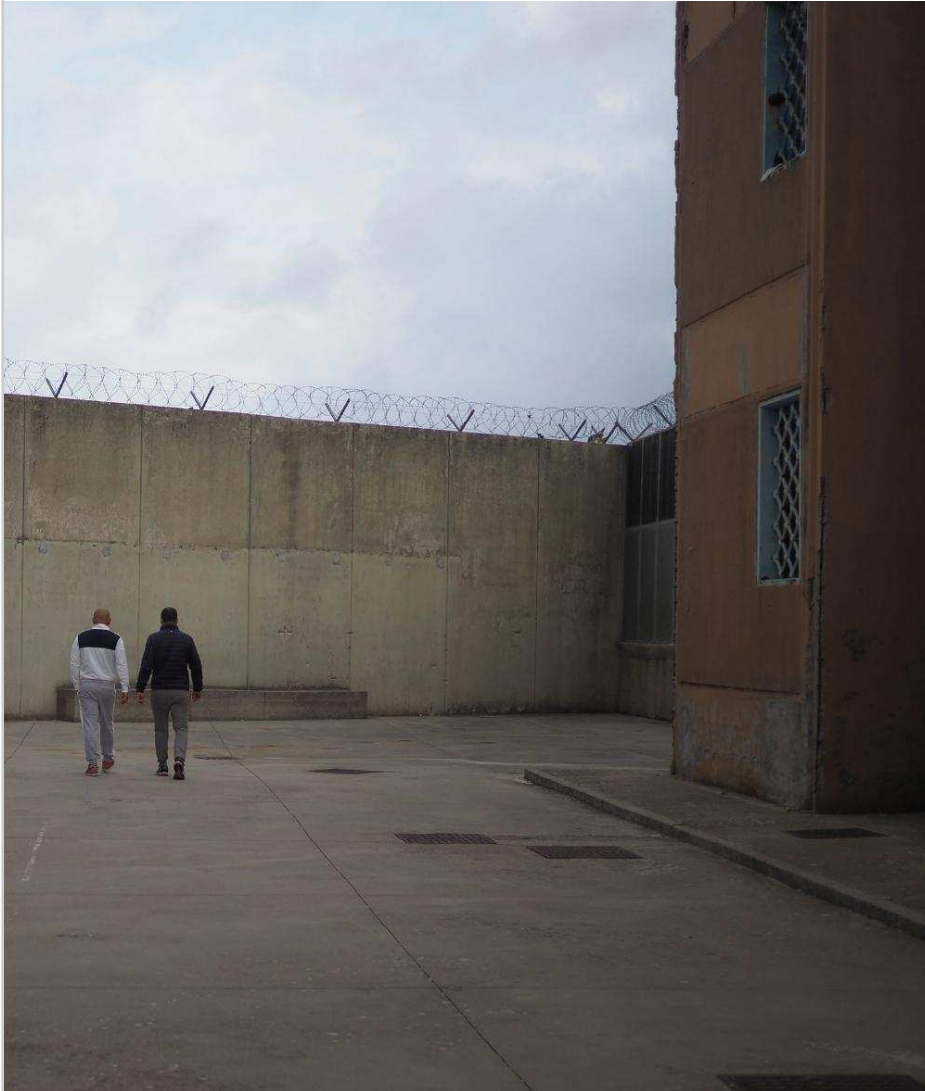
LA CASA CIRCONDARIALE DI LIVORNO «LE SUGHERE», CARCERE DOTATO DI UNA SEZIONE AD ALTA SICUREZZA
